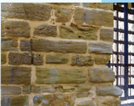
Mur construit en grès fin de la molasse de Carcassonne d'âge Cuisien-Bartonien.
