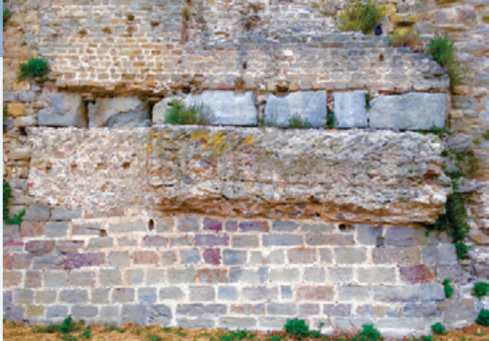
Dans le rempart, mur romain avec les travaux de reprise en sous-œuvre.
