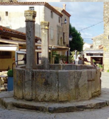
Mur construit en grès fin de la molasse de Carcassonne d'âge Cuisien-Bartonien.
