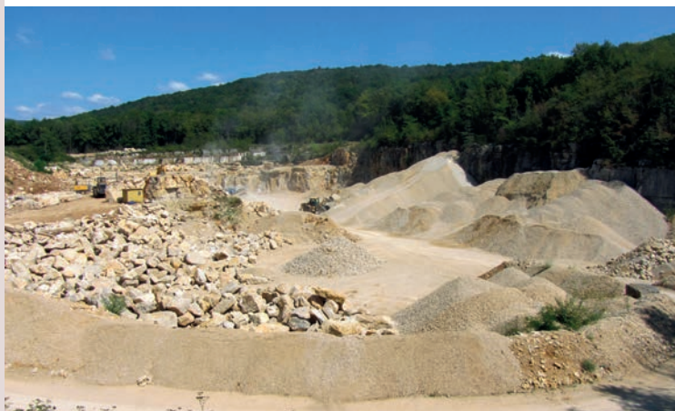
La carrière de Villette et ses deux niveaux d'exploitation : pierre de taille pour le niveau supérieur (au fond) et granulats et enrochements pour le niveau inférieur (premier plan).
