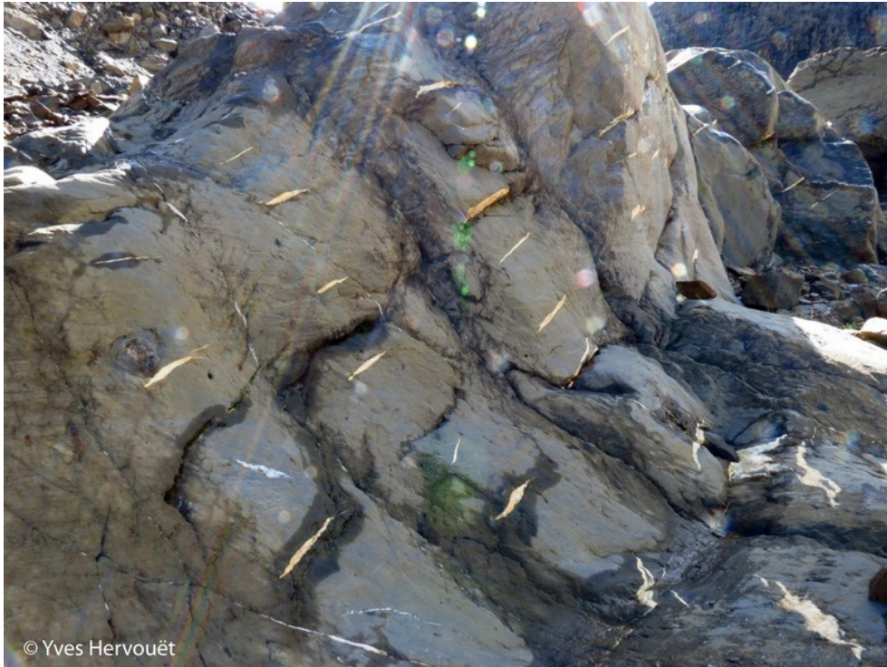
Les fentes de tension disposées régulièrement dans les calcaires du Crétacé supérieur.
