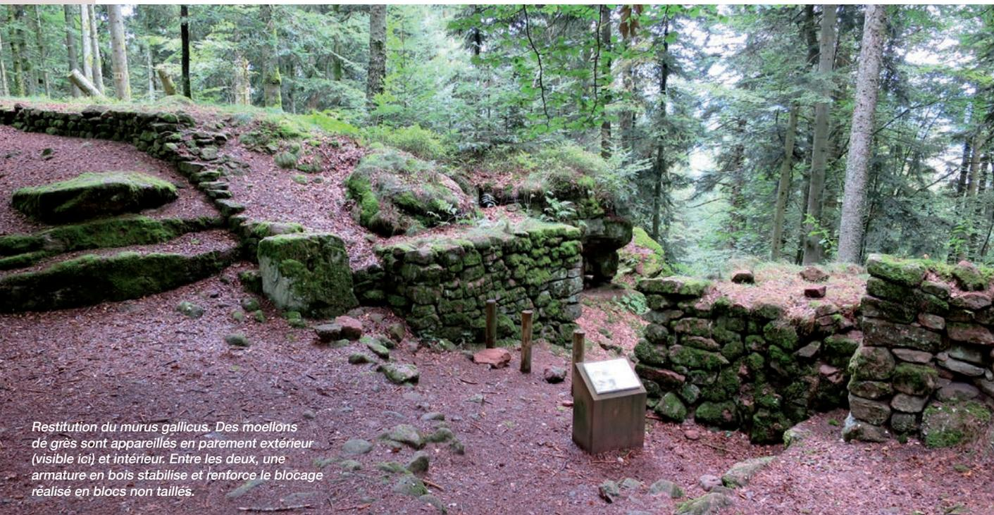
Restitution du murus gallicus. Des moellons de grès sont appareillés en parement extérieur (visible ici) et intérieur. Entre les deux, une armature en bois stabilise et renforce le blocage réalisé en blocs non taillés.
