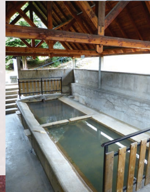
Le lavoir de Chaudes-Aigues est directement alimenté en eaux chaudes.
