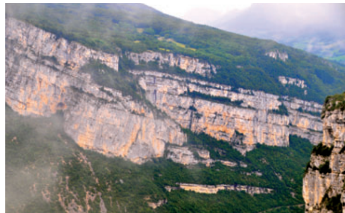
Faille inverse dans les gorges de la Bourne.
