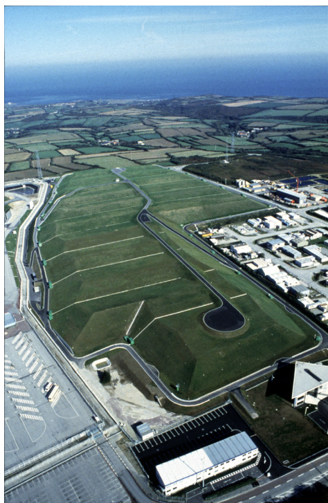
couverture. — Vue aérienne du centre de stockage de déchets radioactifs CSM de l'Andra, situé dans le département de la Manche, après pose de sa couverture.
